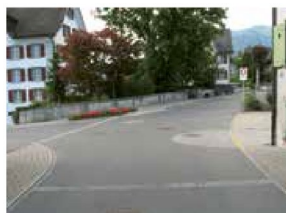
Die halbrunde Pflasterung weist auf einen einmündenden Fussweg und die Querungssituation hin.
