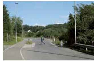
Beidseitige Einengung erhöht die Sichtweiten und sichert die Querung.
