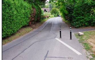
Beidseitige Einengung erhöht die Sichtweiten und sichert die Querung.
