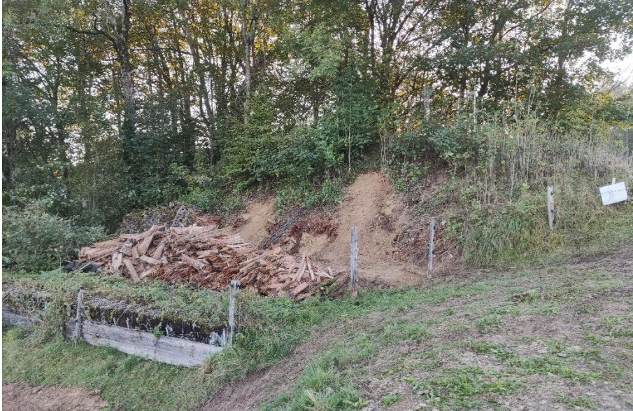
Foto 1: Übersicht Zielbereich (Blick Richtung Westen) nach Ausführung Baggersondierungen und Umlagerung Stirnholz – 23.09.2021
