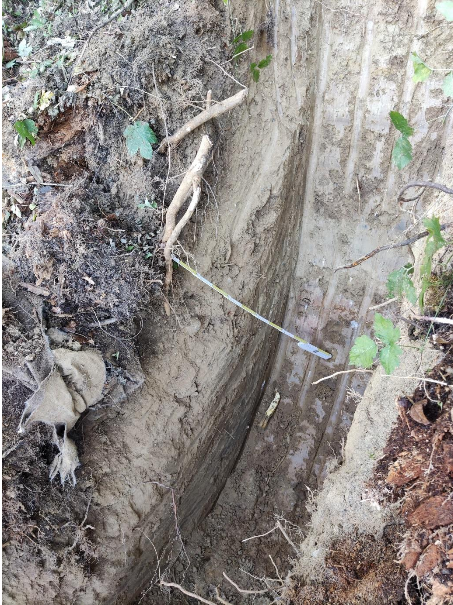
Foto 5: Baggerschlitz BS03/21 im Kugelfangwall– 23.09.2021
