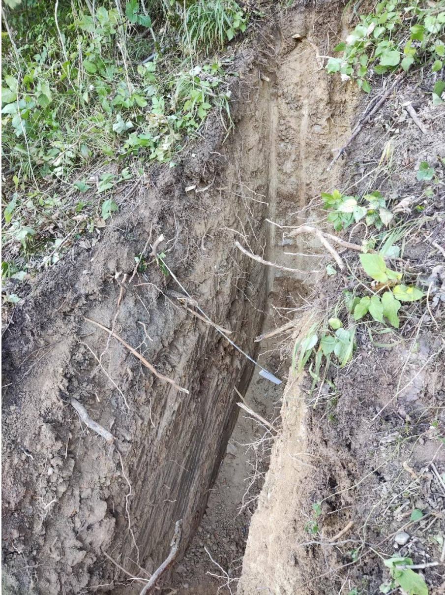
Foto 6: Baggerschlitz BS 04/21 im Kugelfangwall– 23.09.2021.
