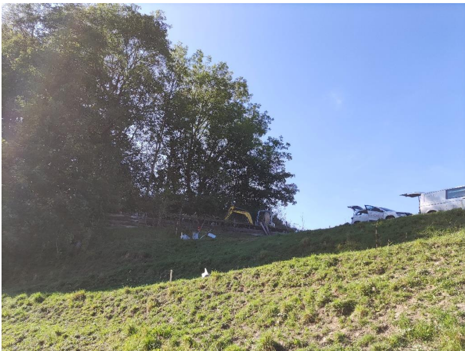
Foto 2: Übersicht Zielbereich aus mehr Distanz (Blick Richtung Nordwesten) – 23.09.2021
