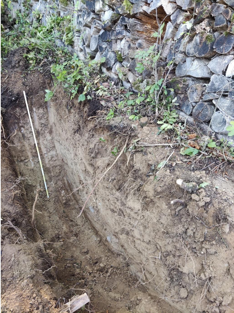
Foto 4: Baggerschlitz BS02/21 zwischen Scheibenstand und Kugelfangwall– 23.09.2021
